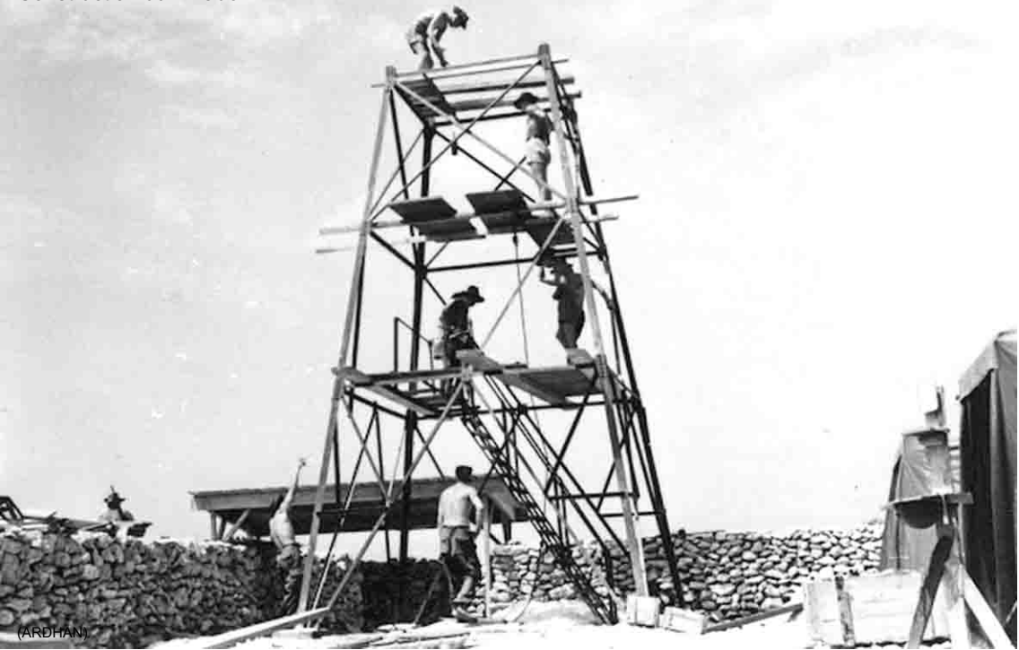
Construction du mirador
