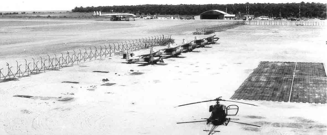
Nord 3400 sur le parking du 3ème PAZES à Touggourt début 1962 - Au fond : un Constellation d'Air France devant l'aérogare civile (Schaudler)
