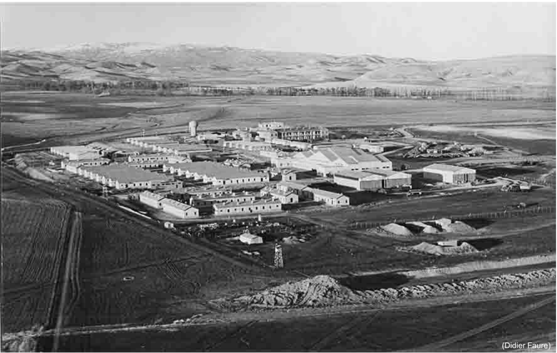
Le Centre d'instruction vu vers le nord, le dépôt de bombes au premier plan à droite
