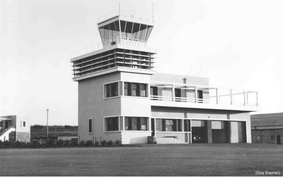
La tour de contrôle et le bâtiment technique vus depuis la piste
