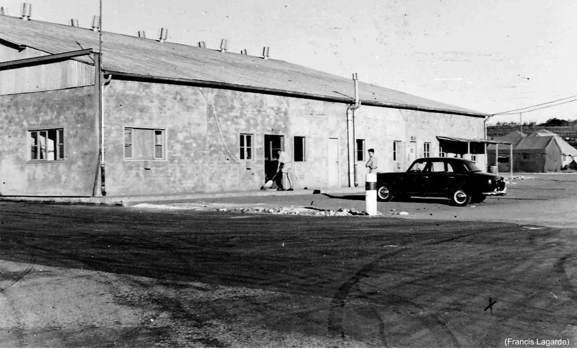
La salle OPS au début de l'installation
