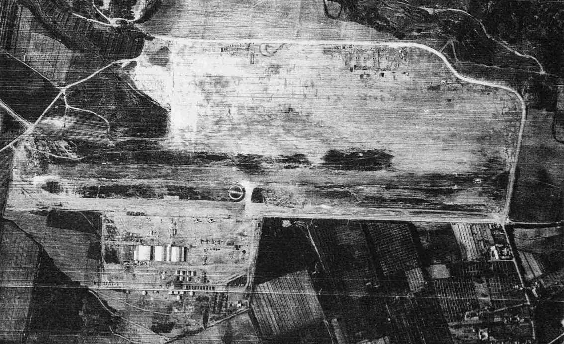
Le 20 mars 1958 – Au sud, les hangars des aéro-clubs sont montés – La piste 08/26 est en service – Les installations de l'ALAT, au nord, sont en construction et l'ALAT est provisoirement du côté aéro-clubs
