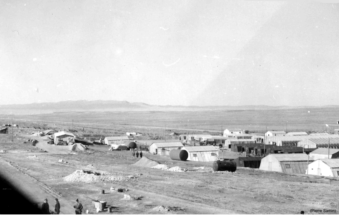
Djelfa – 1956 – Construction de la base – Au fond : Le Senalba
