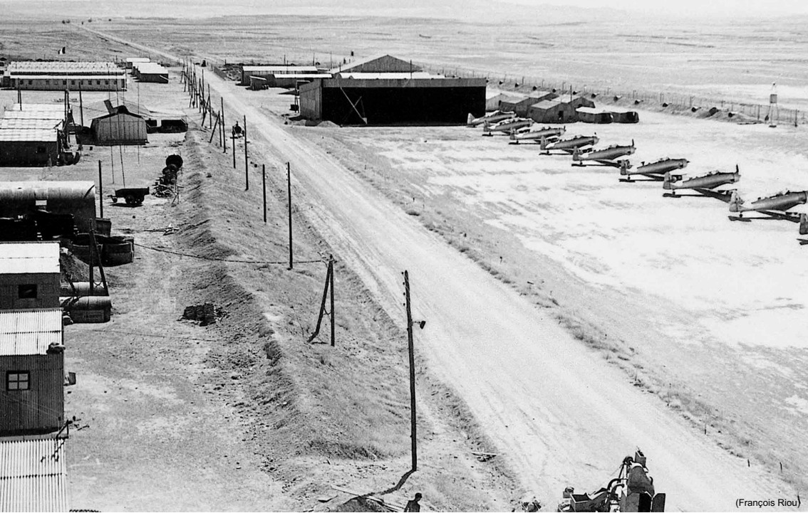
Djelfa – 1956 – Emplacement du hangar de l'ALAT, pas encore construit, à droite près de la piste
