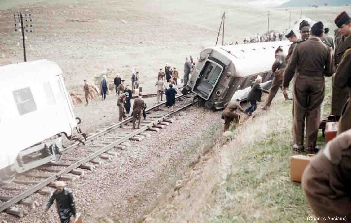
Près du pont sur le Chéouiff – L'Inox après le déboulonnement de la voie par les rebelles – Avril 1959
