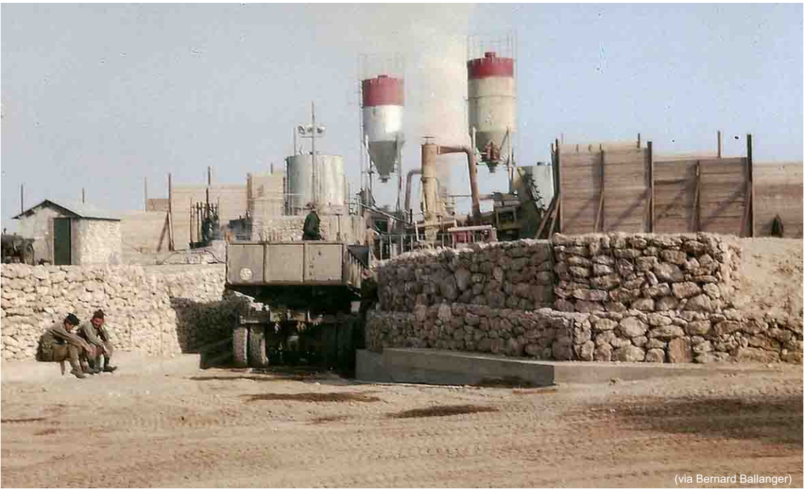
Bou-Sfer – La centrale à béton du 45 ème BAGA pendant la construction de la base
