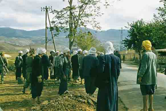
Nédroma – 1956 – Aménagement de l'aérodrome
