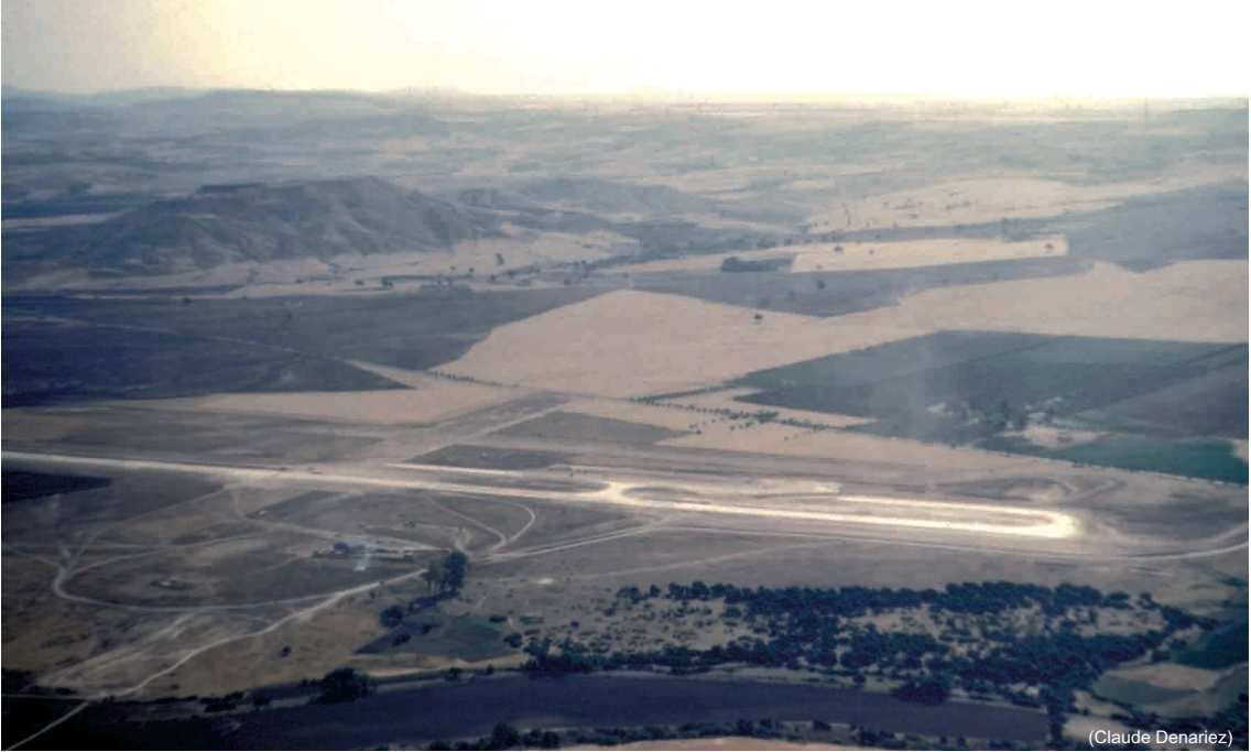
Aérodrome de Saïda – Avant le revêtement, l'aérodrome prend son aspect définitif – L'Aéro-club est au premier plan et des hangars prévus de l'autre côté de la piste ne seront pas construits – Avril 1960
