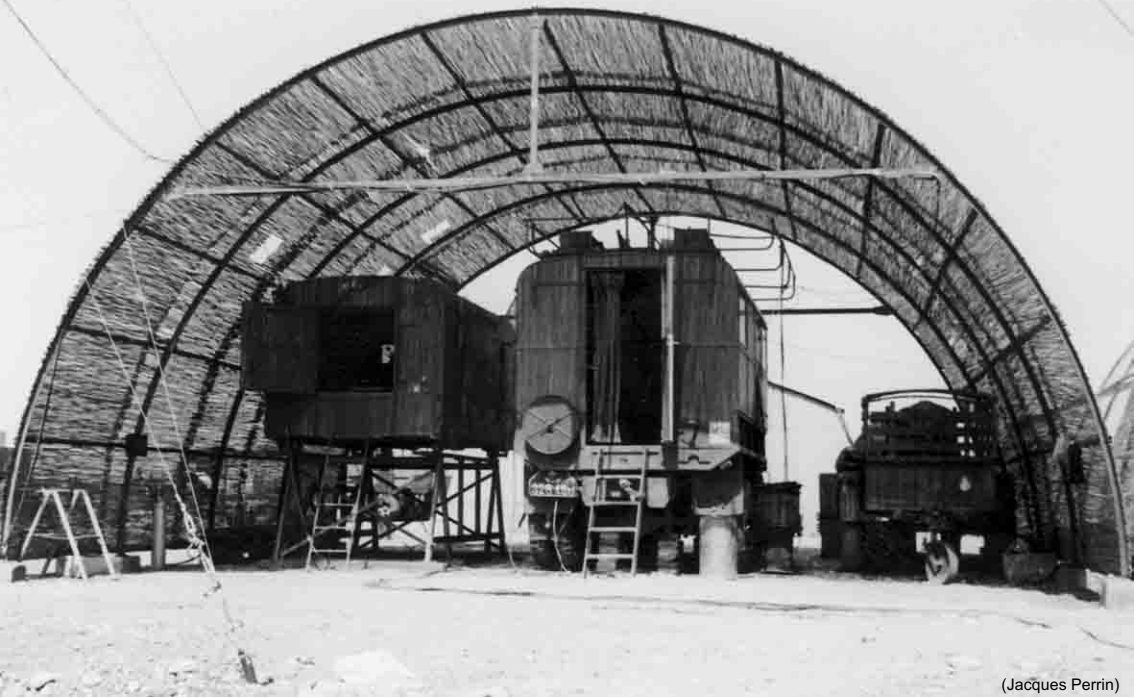
Aérodrome d'El-Abiod – Installation radio
