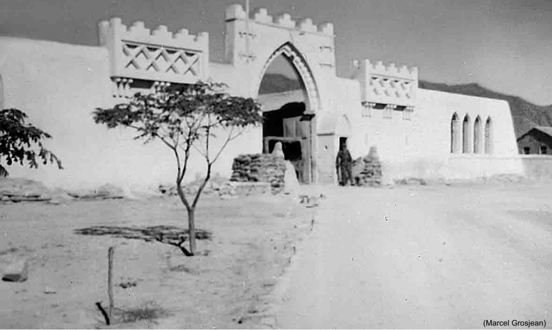
Méchéria – Entrée de la Redoute, ancien fort de la Légion Étrangère où est installé le PCA 27/540
