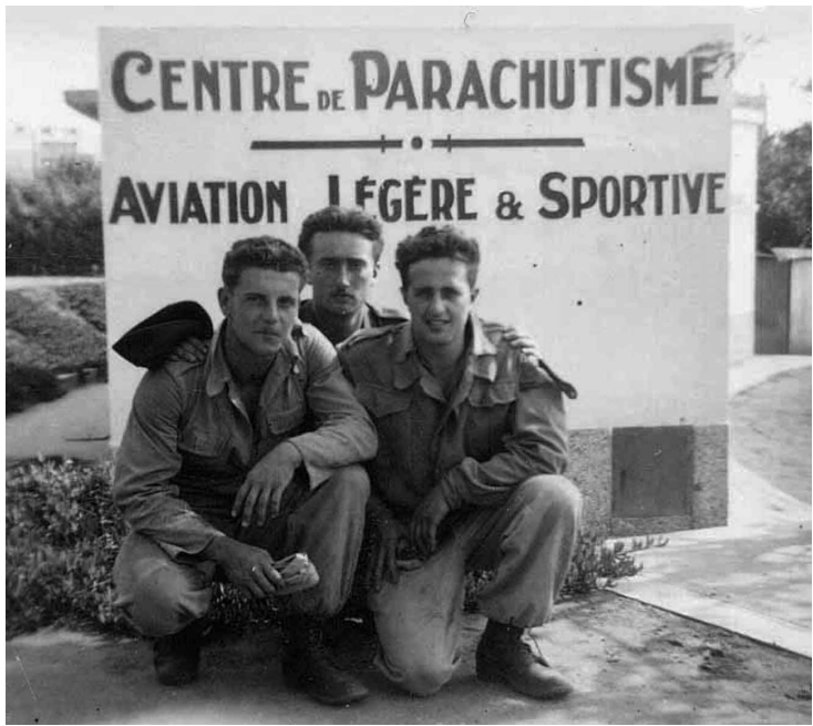
En 1948, au Champ-de-Manœuvres à Alger où une tour à parachute a été installée en 1946 (Paul Vincennes)
