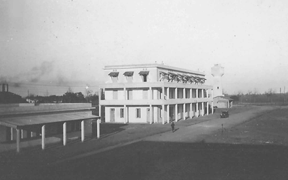
Installations militaires de Maison-Blanche en 1936 (archives privées)
