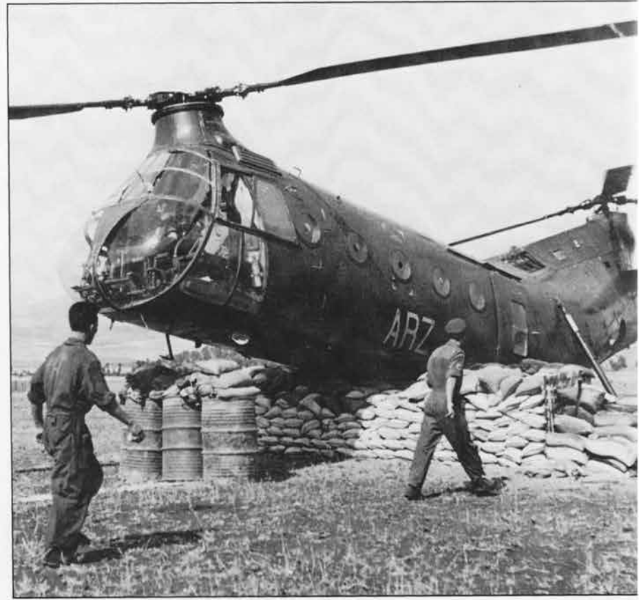
Recueil d'un H-21C victime de la rupture du train arrière droit en opérations. Une vingtaine de berceau de crash était répartie sur l'ensemble de l'Algérie, éléments destinés à recueillir en toute sécurité les "Banar" souvent victimes de problèmes de train d'atterrissage avant ou arrière lors de posers sur les pitons. (Jean Coispeau)
