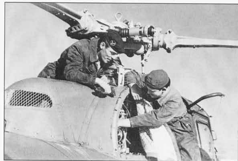
Capotage ouvert, intervention de mécaniciens sur le ventilateur refroidissant le circuit d'huile d'un S-55. (Louis Barrois)
