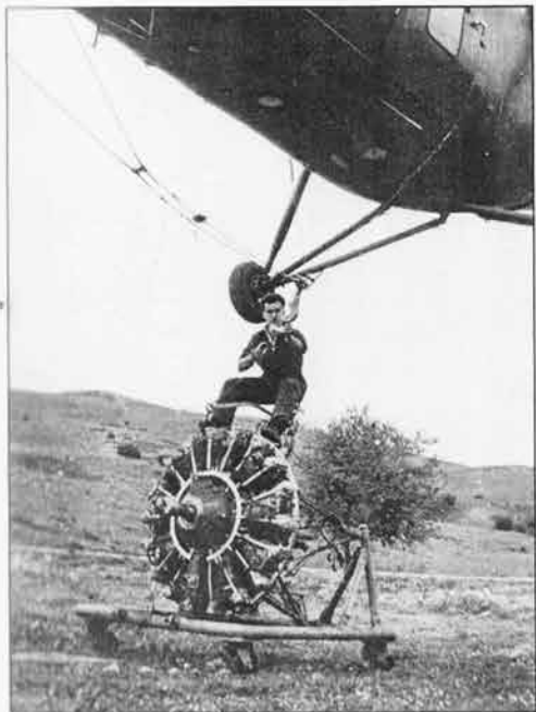
En opérations, dépose sur son bâti d'un moteur Wright d'un H-21C puis hélipontage en sling par une autre "Banane". (coll Cortès et DR)
