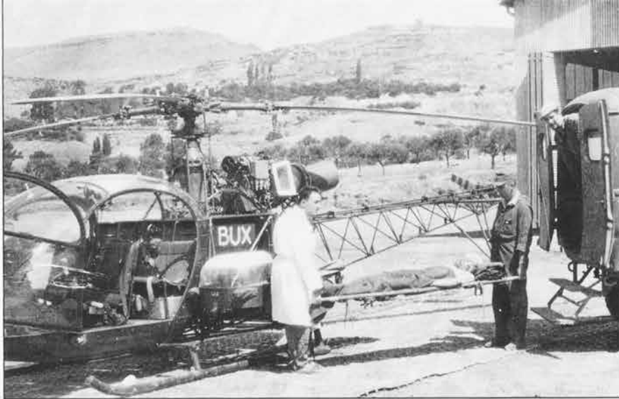
Transfert d'un blessé entre le plateau SIREN de l'appareil et le véhicule sanitaire. L'Alouette II offre un départ en intervention pour des EVASAN plus rapides que ceux nécessaires aux avions. (Louis Chupin)
