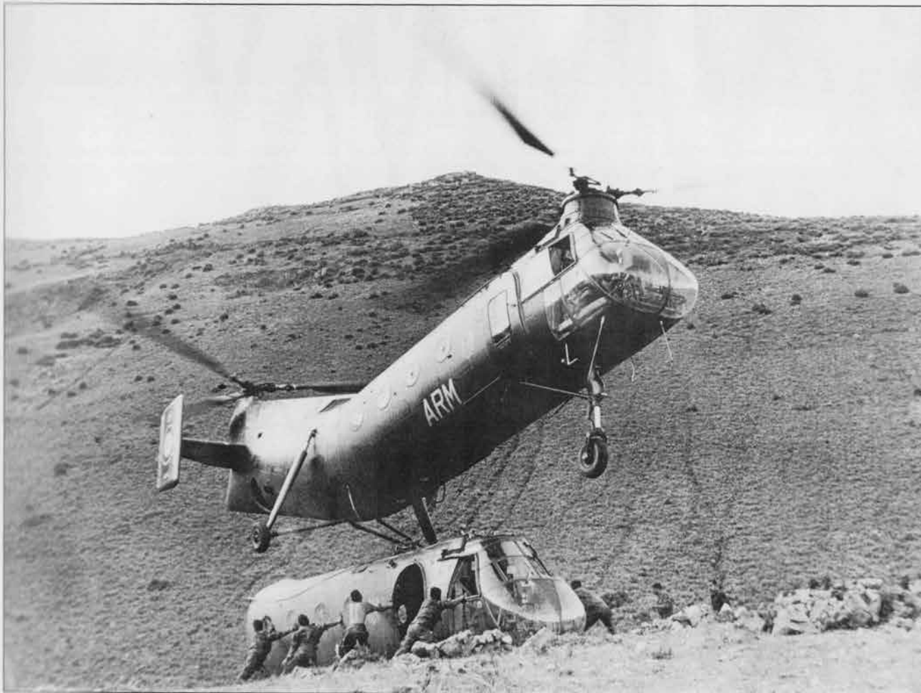
Récupération en cargo sling par le FR 97 de la section avant du FR 93 accidenté. (Jean Gomanne)
