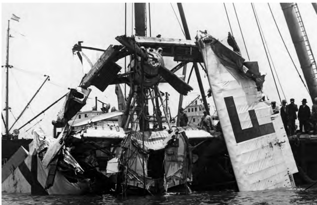
22 mai 1929 - Accident dans le port d'Alger (Maurice Cre- tot)
