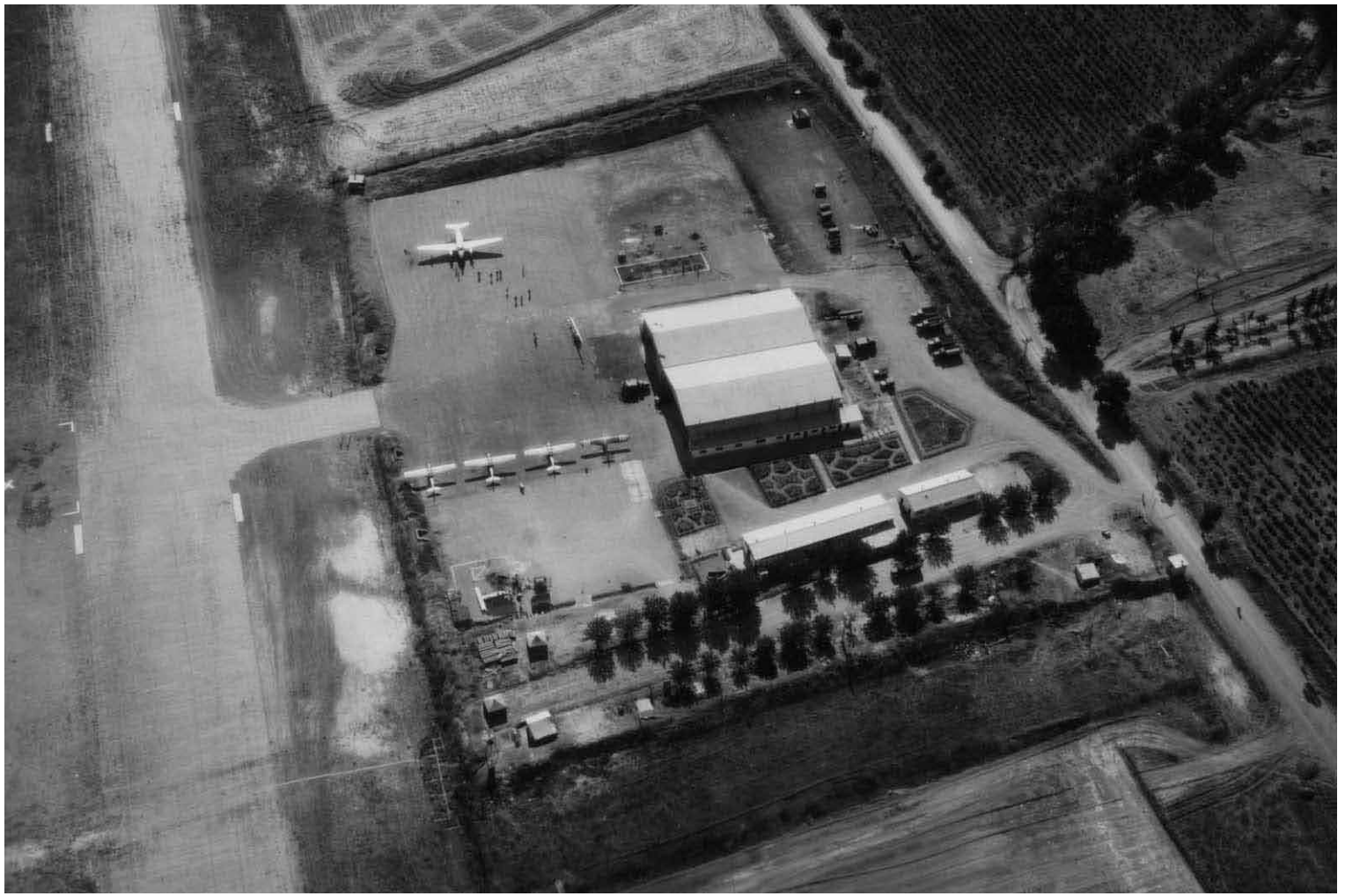
▲ Les installations du Peloton en 1960. Des bâtiments et la salle OPS sont en construction en haut de la photo, de l'autre côté des hangars
