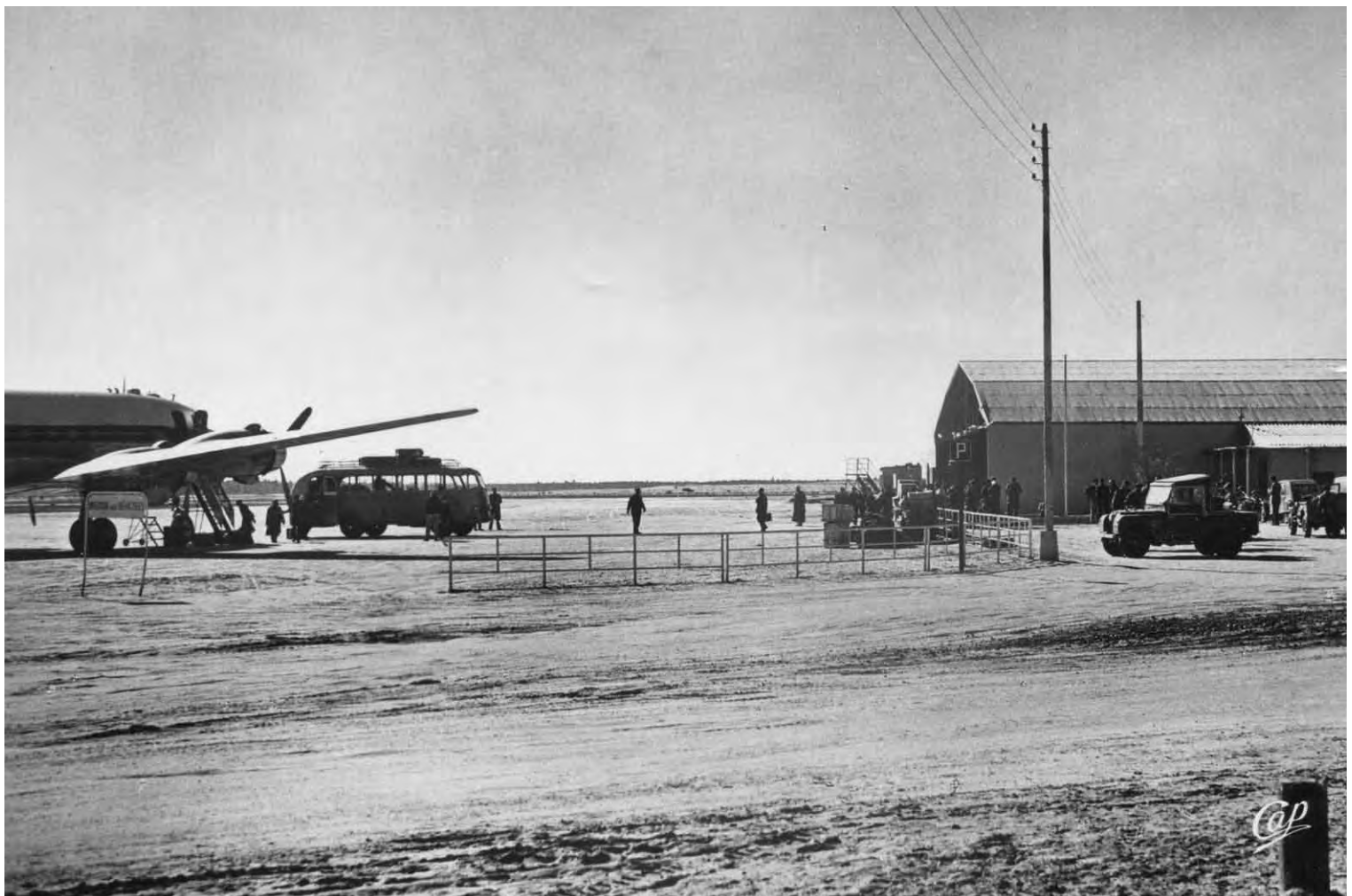
▼ DC 4 à Touggourt, devant le hangar de l'Aéro-club
