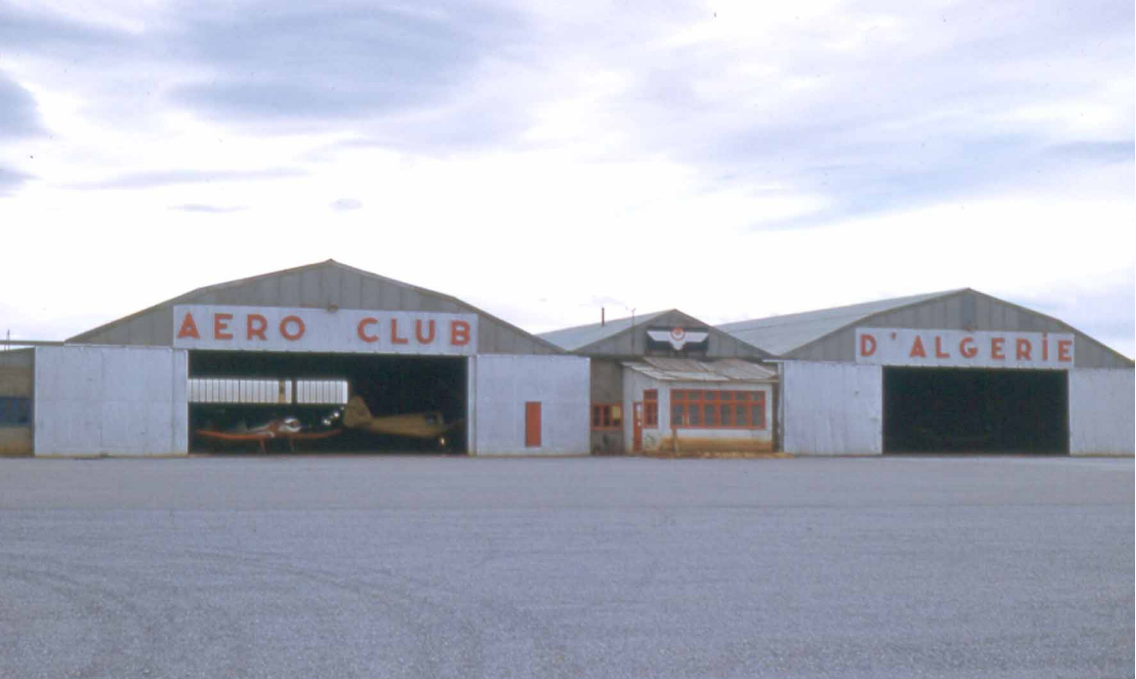
Après avoir été déménagés une première fois à Maison-Blanche pour la construction de la piste 06/24, les hangars de l'Aéro-club sont transportés et remontés à Chéragas (Yves Quiniou)
