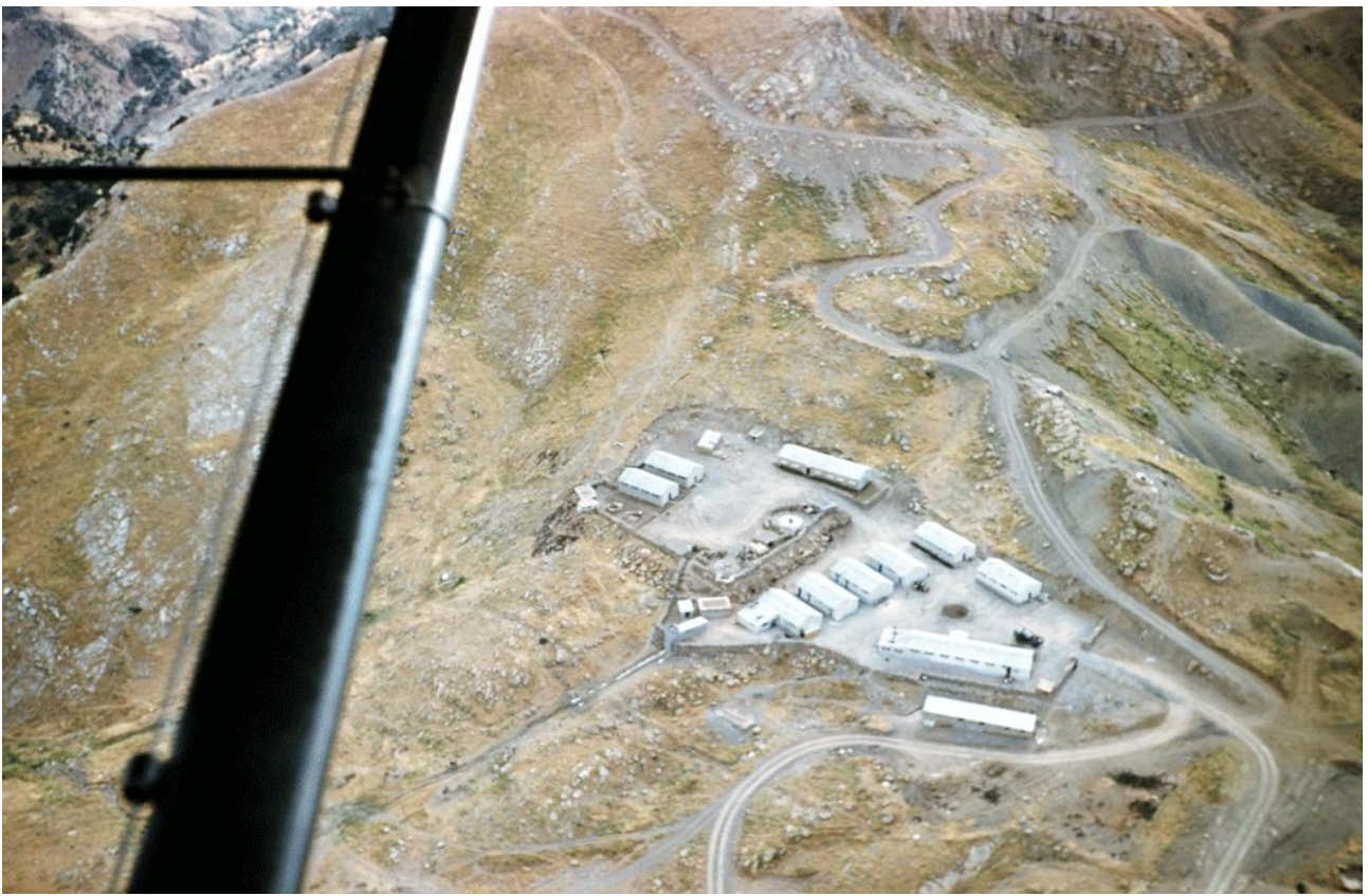
Un poste isolé, au sommet d'une montagne (côte 1450).
