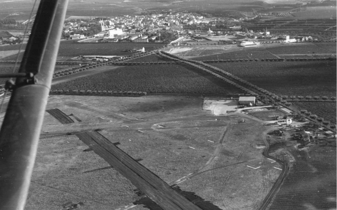
L'aérodrome d'Aïn-Témouchent en 1957, pendant la construction de la nouvelle piste (Claude Marigot)
