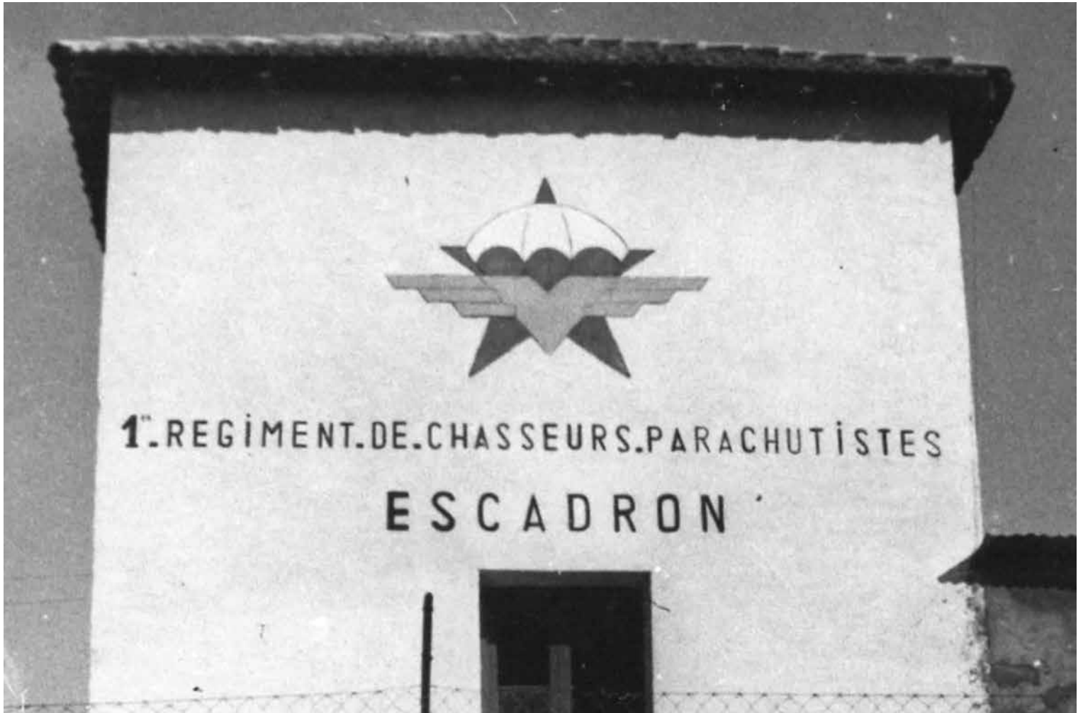
▼ Le poste de garde, construit par les gars de l'Escadron avec des matériaux récupérés en partie sur des ruines
