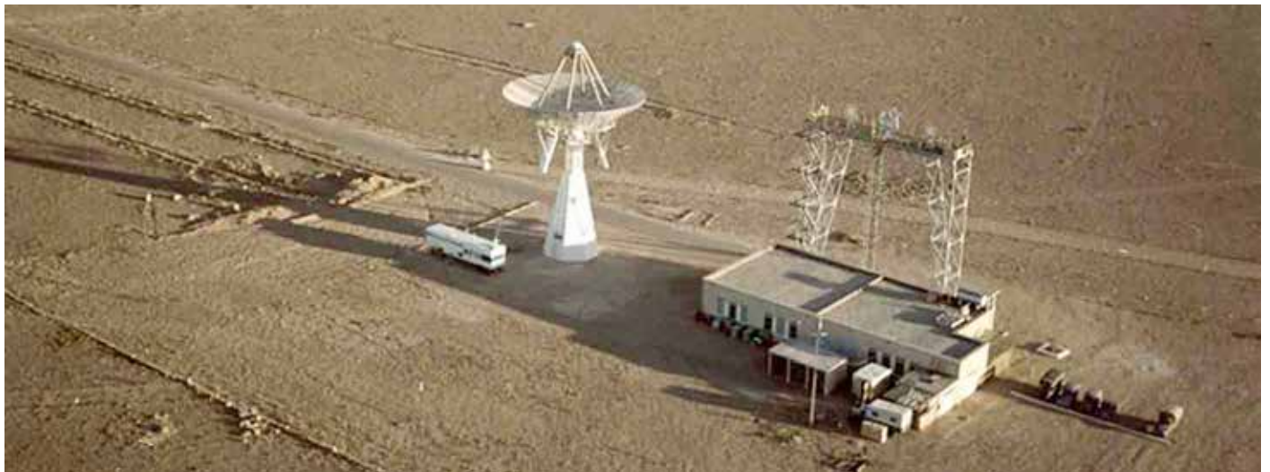
▲ La station de télémétrie avec l'antenne géante Cyclope qui pèse 35 tonnes et mesure 27 mètres de hauteur ▼ Radars de suivi
