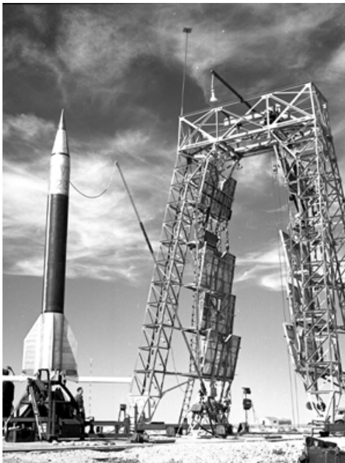
Assemblage final de la fusée Véronique AGI V23 et installation sous le portique, puis le portique est dégagé de la fusée avant son lancement qui sera un échec le 23 février 1960
