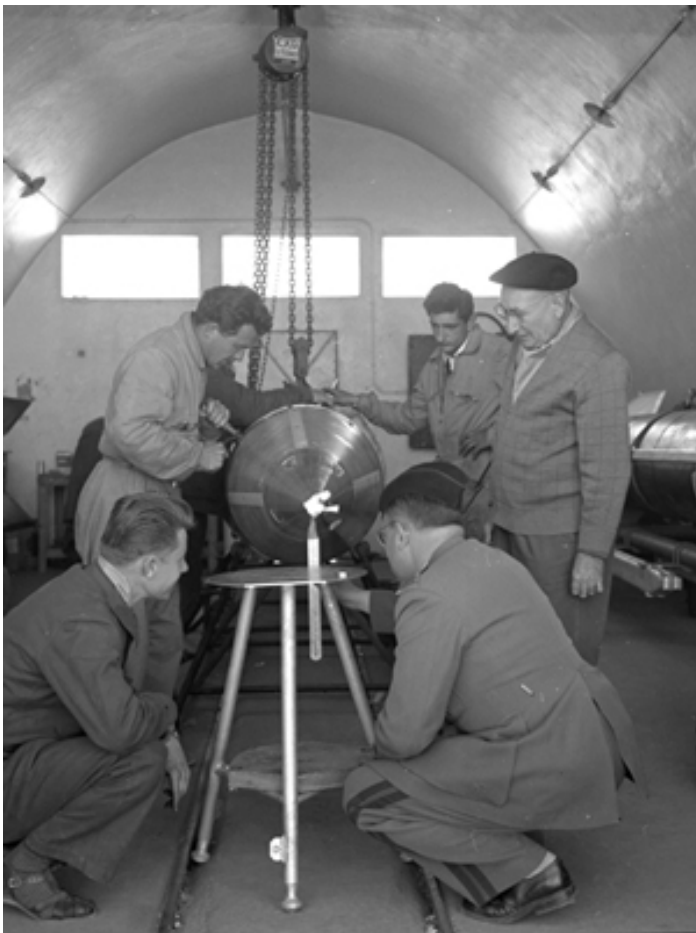
Assemblage final de la fusée Véronique AGI V23 et installation sous le portique, puis le portique est dégagé de la fusée avant son lancement qui sera un échec le 23 février 1960
