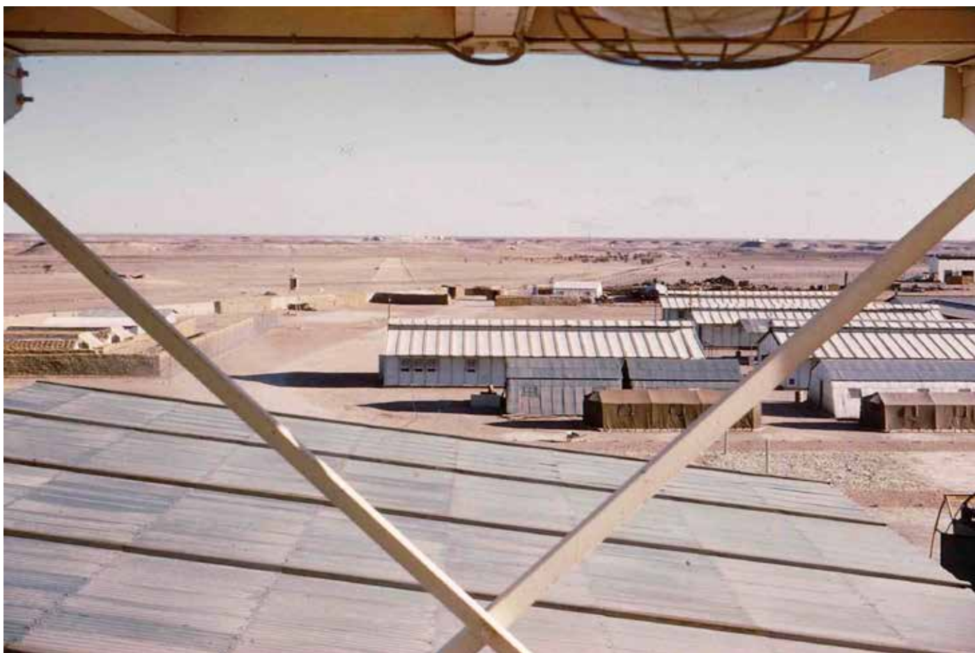
▲ Tindouf, la Base vue de la tour de contrôle
