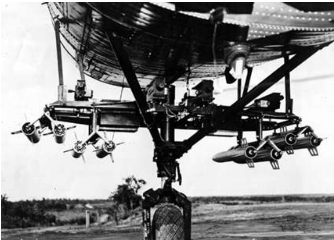
Deux vues d'un bâti expérimenté par l'US Army vue le 23 avril 1957. On note la présence de deux mitrailleuse de 0.30, 2 de 0.50 ainsi que huit roquettes HVAR. Le modèle fourni au GH N°2 était légèrement différent (photo X, via Emmanuel Bosc).
