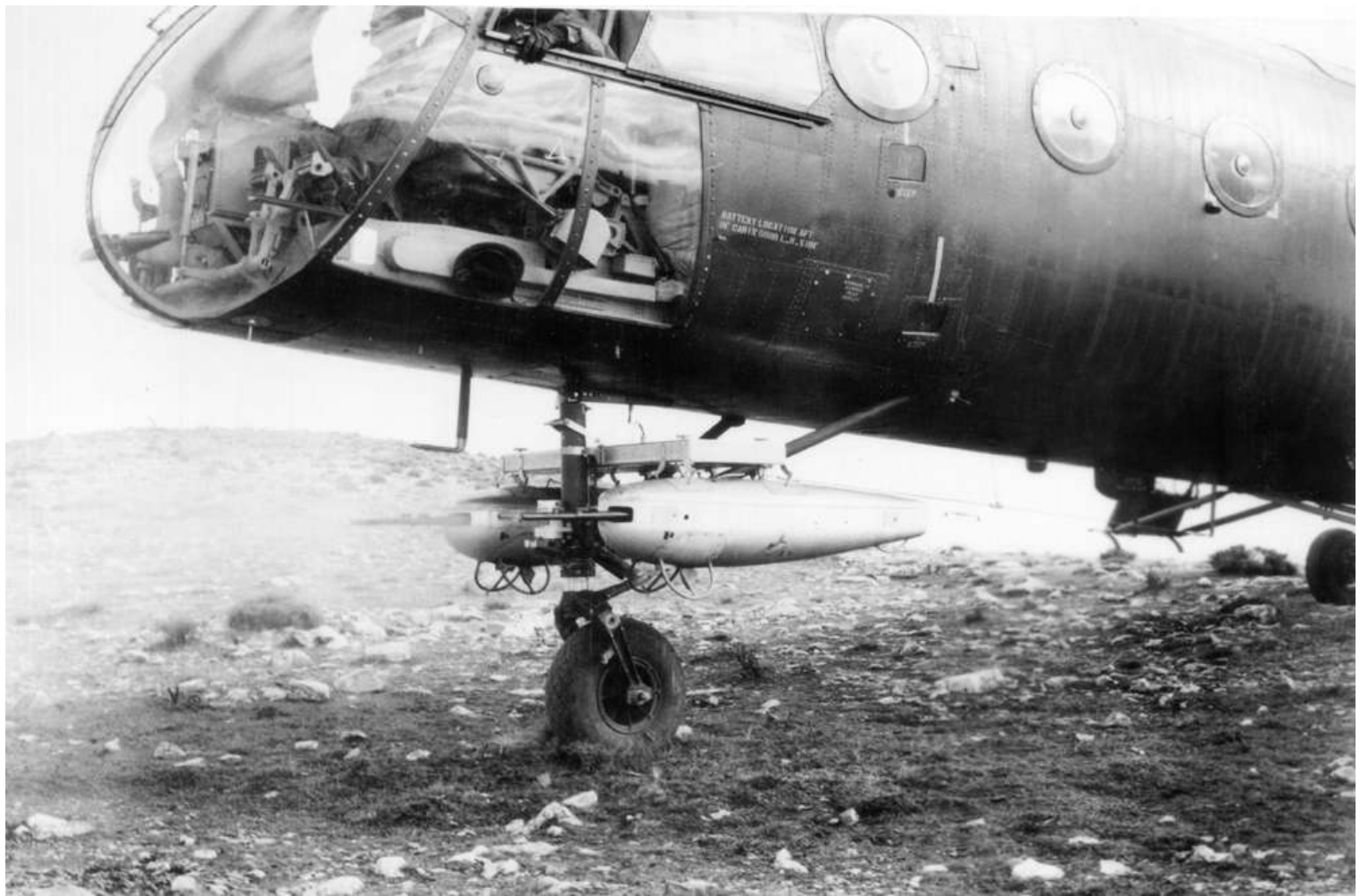
Tir au sol à partir des containers SAMM 410 à deux mitrailleuses de 7,5 mm lors des expérimentations de mai 1958. Notez le support de panier de roquette à droite (photo GE.ALAT).
