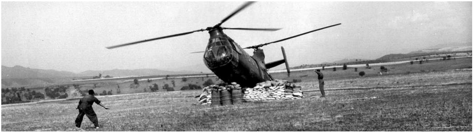
FR03/ARZ du GH N°2. Atterrissage sans train droit sur un berceau improvisé, dans la région de Guelma, en 1960 (photo X, via Suzy Debaralle).
