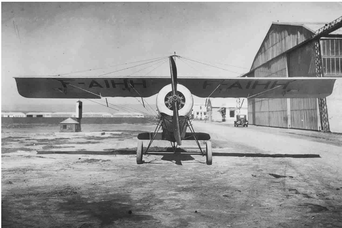
▲ ▼ Le Morane 35 de la Compagnie aérienne français (CAF) à La Sénia, semblable au F-AIJG utilisé par Pierre Monville pour l'école de pilotage de l'Aéro-club d'Oranie. La profusion des cordes à piano assure la rigidité de l'ensemble
