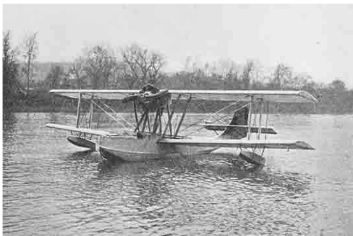
Le Lioré et Olivier LeO H-194, moteur Gnome et Rhône 9ab, 420 ch
