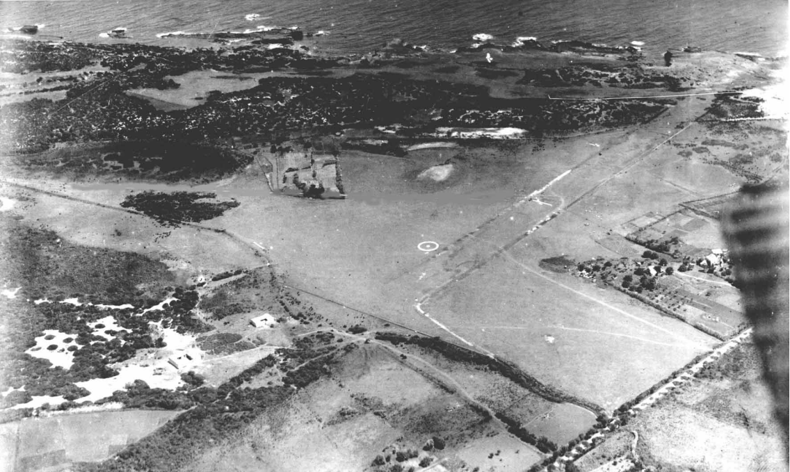
L' aérodrôme de Djidjelli en juin 1932, lors de sa construction. La piste initiale est perpendiculaire à la piste 09/27 qui sera construite par la suite (Eugène Fauché)
