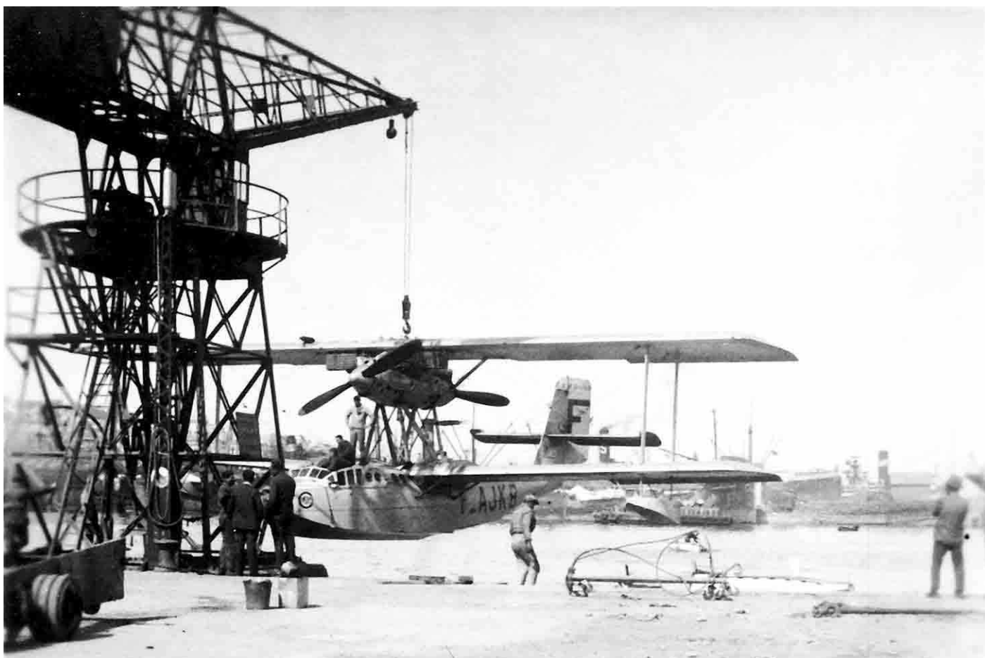
▼ Le 20 mars 1930 , mise à terre du CAMS 53 F-AJKB à l'hydrobase de l'Agha par la grue derrick
