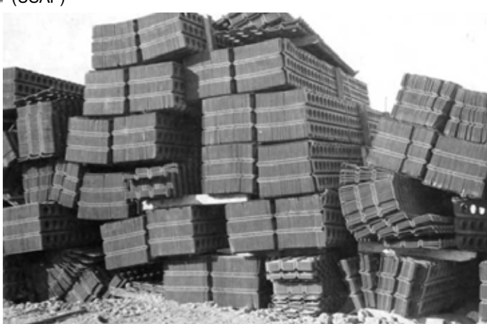
Les plaques PSP Pierced Steel Plank destinées au revêtement (USAF)
