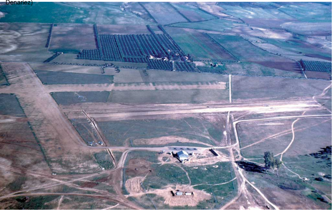
En avril 1960, l'aérodrome de Saïda et le hangar de l'Aéro-club pendant les travaux sur les pistes (Claude Denariez)
