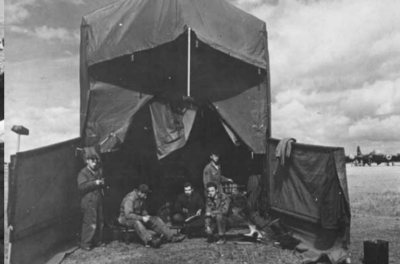
Aïn-M'lila, février 1943 – 301st BG – Abri mobile pour changement de moteur, et moteur de B-17
