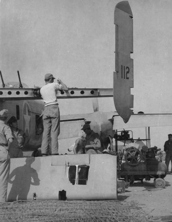
Ce B-25 a été endommagé sur la Sardaigne à la dérive, au fuselage et à un fuseau moteur par un Bf 109 qu'il a ensuite abattu
