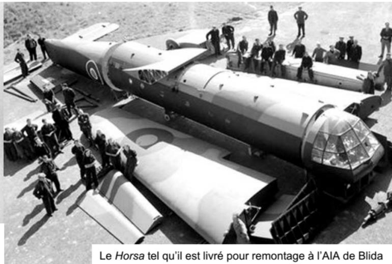
Caractéristiques : 28,84 mètres d'envergure, 20,43 mètres de longueur, vitesse de remorquage : 240 km/h, vitesse de plané : 160 km/h, 27 hommes y compris deux pilotes, poids à vide : 3 800 kg, poids en charge : 7 030 kg, 3 644 exemplaires construits.
