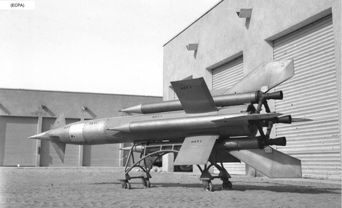
Missile antiaérien radioguidé à propulsion solide PARCA, en 1958
