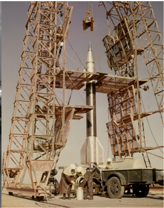
Assemblage final de la fusée Véronique AGI V23 et installation sous le portique
