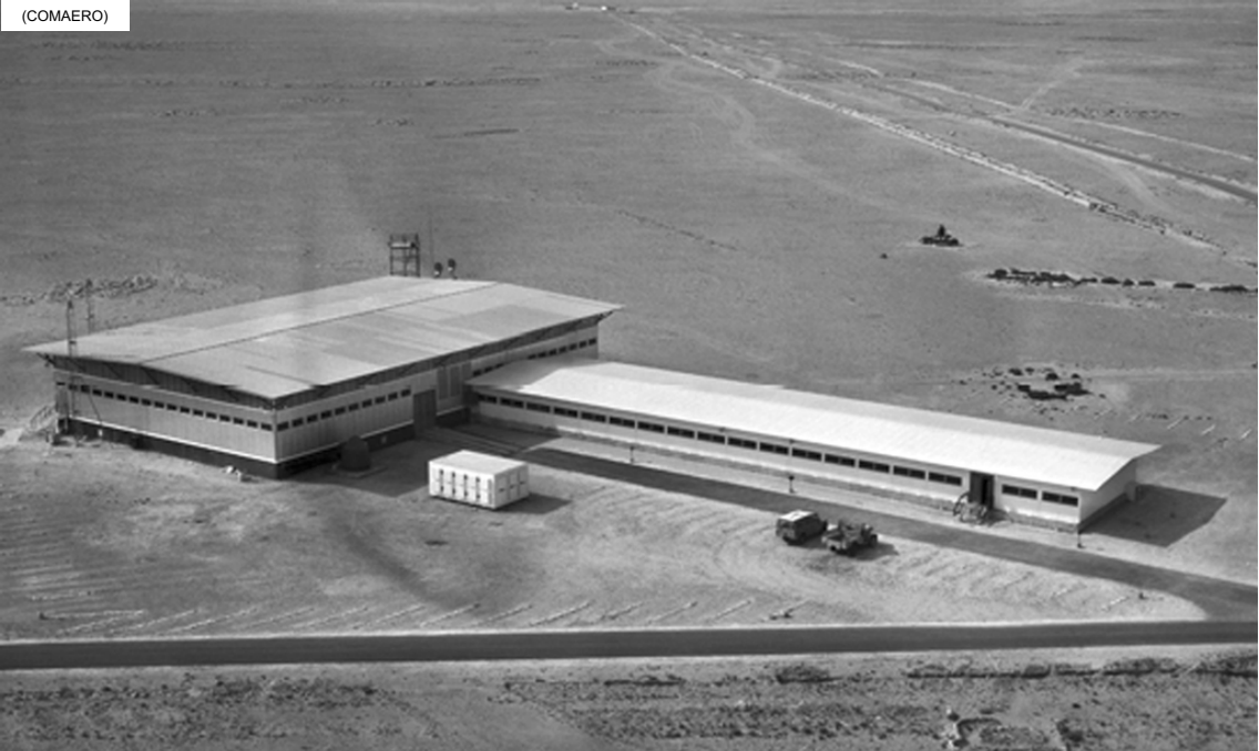
PCCT – Poste de commandement pour engins balistiques, chargé de centraliser et de coordonner tous les tirs effectués depuis les bases Blandine , Bacchus , Béatrice et Brigitte . Il accueille les journalistes et les invités. Il a été construit après le réaménagement des champs de tir de 1958 à 1963
