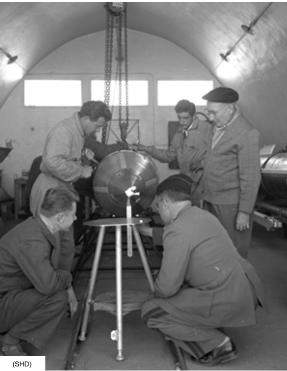
Assemblage final de la fusée Véronique AGI V23 et installation sous le portique
