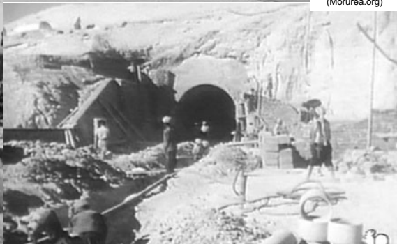
Construction d'un laboratoire souterrain
