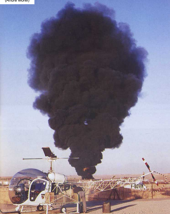
Purge d'un forage avant l'exploitation
