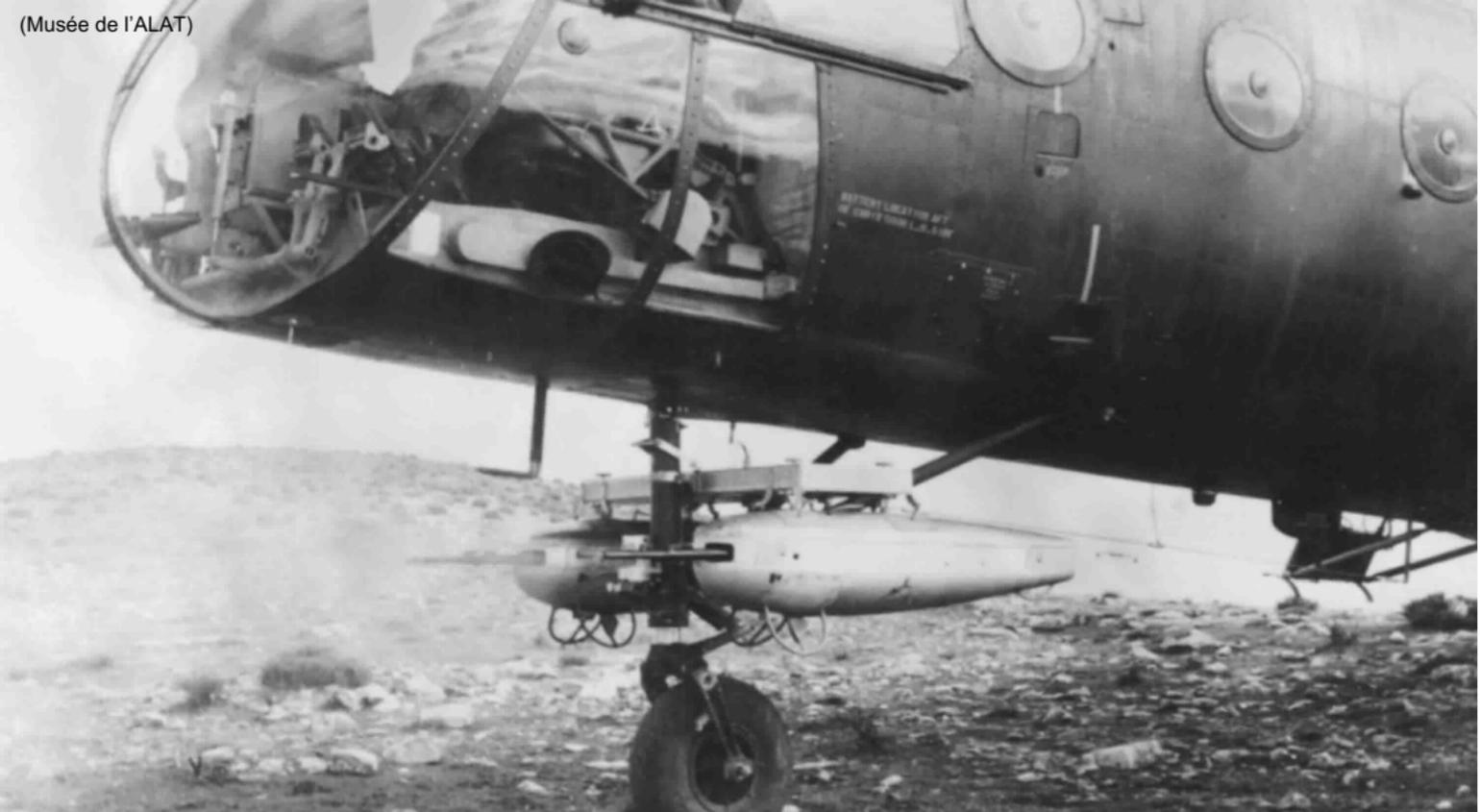
En mai 1958, essai de tir au sol à partir des deux conteneurs SAMM 410 empruntés aux T-6 (quatre mitrailleuses AA 52 de 7,5 mm). Le carénage en goutte d'eau sur le dessus des conteneurs n'existe pas sur les T-6 où le conteneur affleure l'intrados de l'aile. Le support d'un panier de roquettes est visible à droite
