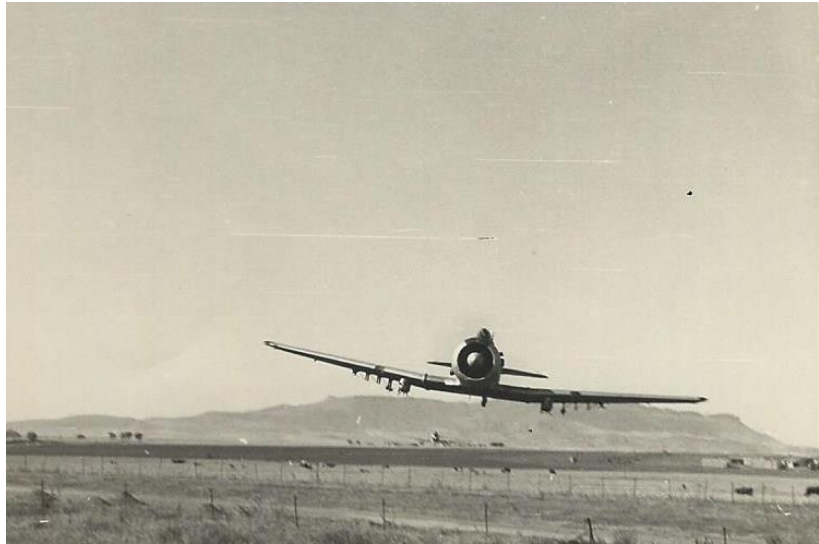
Passage au ras du sol
