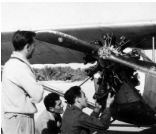
▲ Gustave Camilieri au cours d'une intervention sur le carburateur du Caudron 109 F-ALVC, un vétéran qui ne peut être maintenu en état de vol, dans les conditions climatiques difficiles du Sahara, que grâce à des soins constants (GC)
