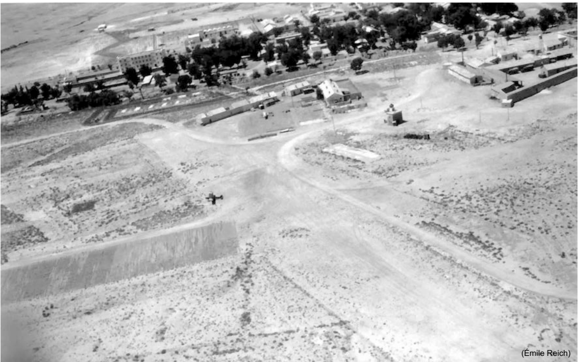
PMAH 12 ème DI – Aérodrome d'El-Aricha, 1961
