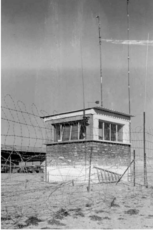
M'Sila 1960-1961, la tour de contrôle
