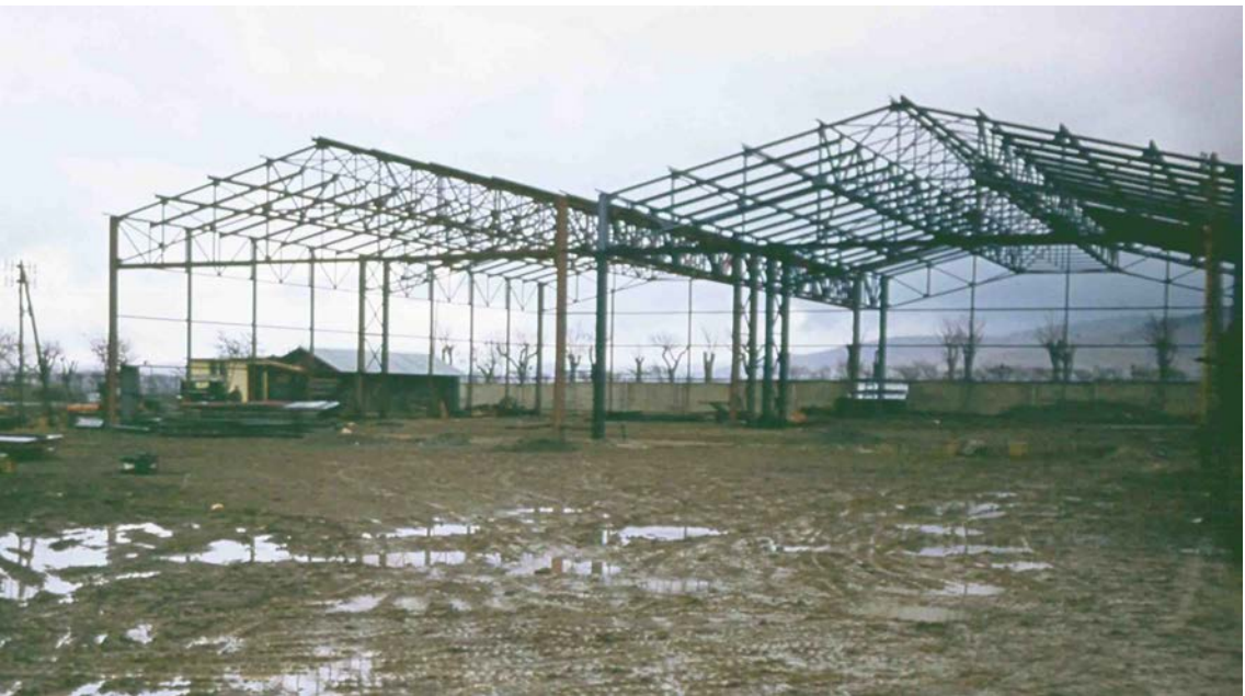
1 er PMAH 21 ème DI – Batna, 1959, montage des hangars du Peloton
