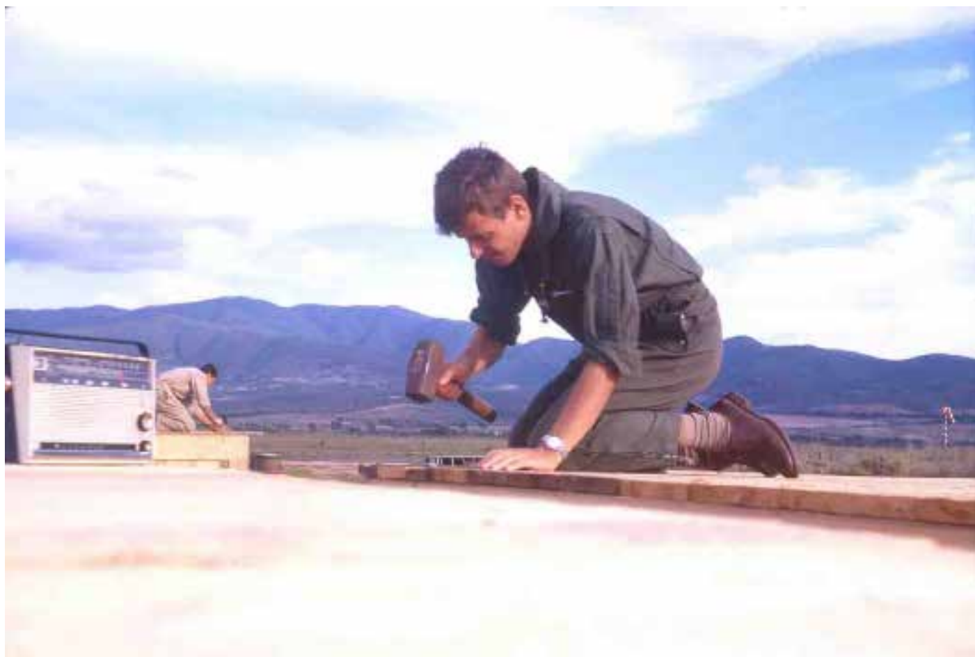
▲ PMAH 2 ème DI à Philippeville, déménagement
